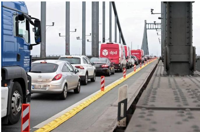
*Bildunterschrift: Mit einem deutlich geringeren Gewicht als Betonwände lassen sich die BaSt-geprüften Leitschwellen von horizont schnell und einfach montieren, versetzen oder demontieren.*
