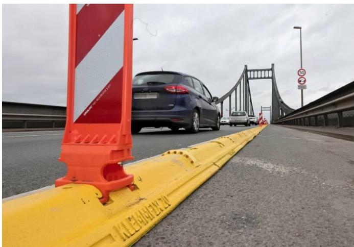
*Bildunterschrift: Die mit Reflektoren ausgestatteten Leuchtbügel zeichnen auch bei Nacht die Konturen der Leitschwelle nach: Das sorgt auch bei schlechten Sichtverhältnissen für eine klare Orientierung der Verkehrsteilnehmer.*
